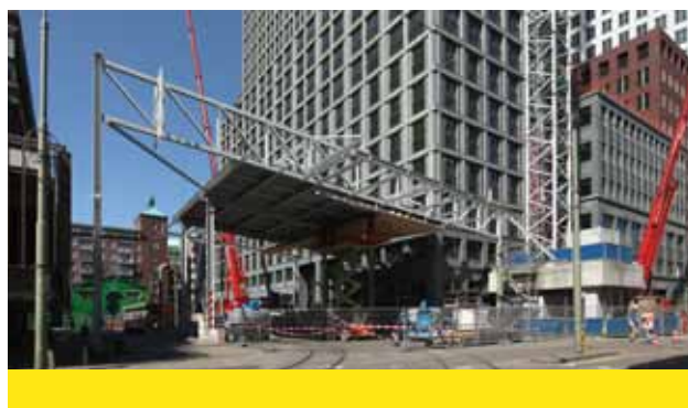
Verwijderen van de tramoverkapping
