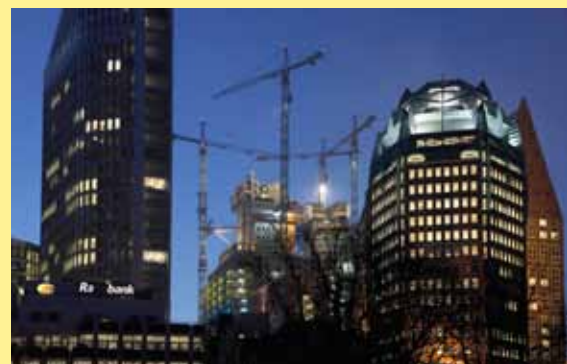
De voortgang van de bouw vanuit verschillende punten in de binnenstad.
