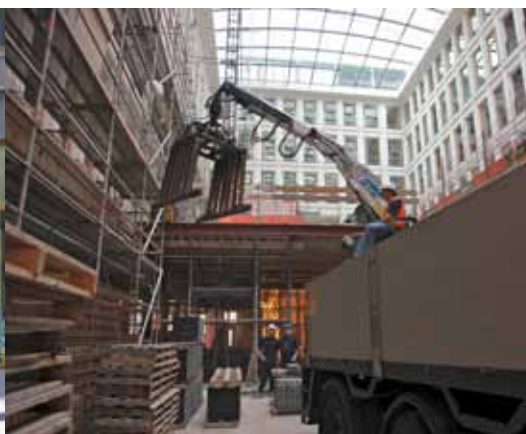
Werkzaamheden in atrium de Kroon
